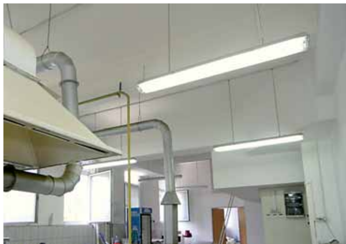
agățător suspensii / suspension hanger
