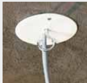
Doza KBT... acoperită cu capacul V 68 S cu conductor scos și cu cârlig pentru candelabru KBP...
