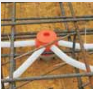
Exemplul de folosire pentru cofraj orizontal.
