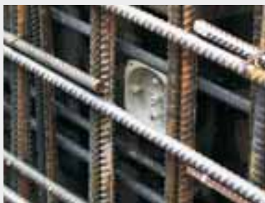
Capacul KBV fixat pe cofraj.
