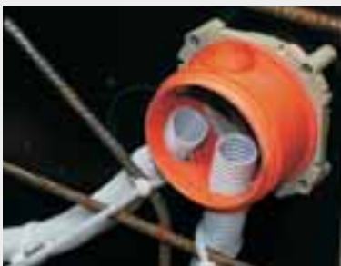
Tuburi flexibile montate în corpul KBT.
