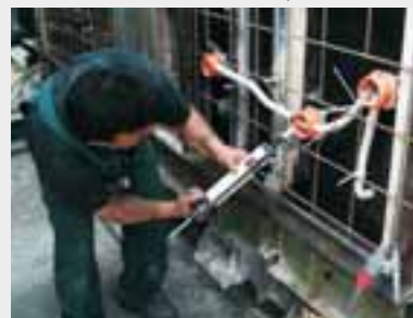
Etansarea permeabilității (chit).
