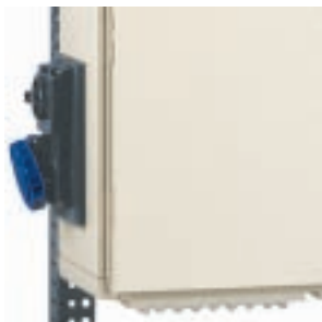
Montaj prize de curent pe lateral
